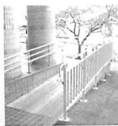
正面入口横に設置されたスロープ
