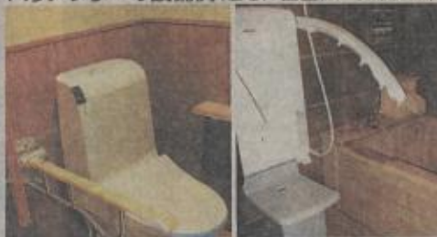
手すりがついた客室のトイレ 座シャワーを備える浴室
