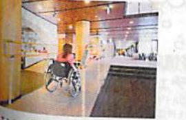
エントランスには階段があるが、スロープが設置されているので車イスでも回避可能
