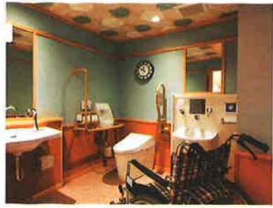
洗面台が2つあり、1つは車いすのまま利用が可能。オストメイト対応のトイレも設置されている。 写真提供◎なにわ一水
