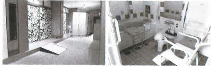
宴会場の入口に設置された仮設スロープ
